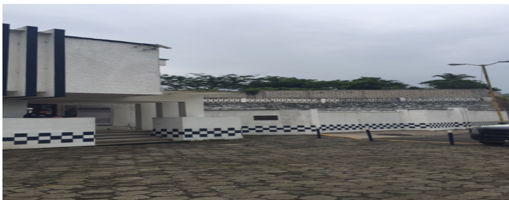
Entrada a las instalaciones de Seguridad Pública
